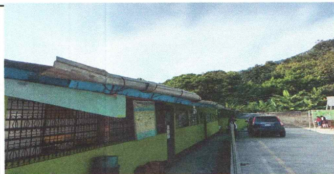
Foto 5: Sustitución de canal de metal
