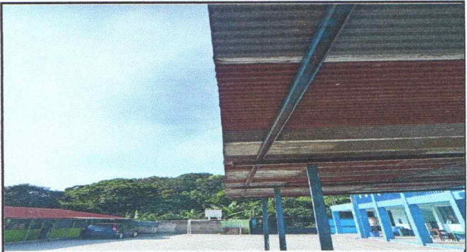
Foto 4: Sustitución de canal de PVC
